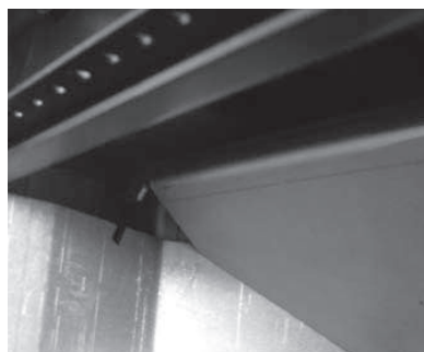
Fig. 15: soulever la plaque coupe-flamme
